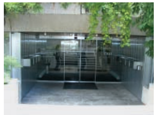
Abbildung 2 Durch diesen Eingang betreten Sie das FMH-Generalsekretariat.
