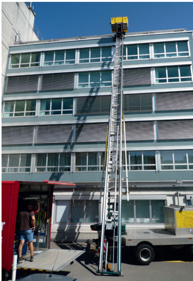
Grue avec ascenseur pour le transport des cartons au 6 e étage...
