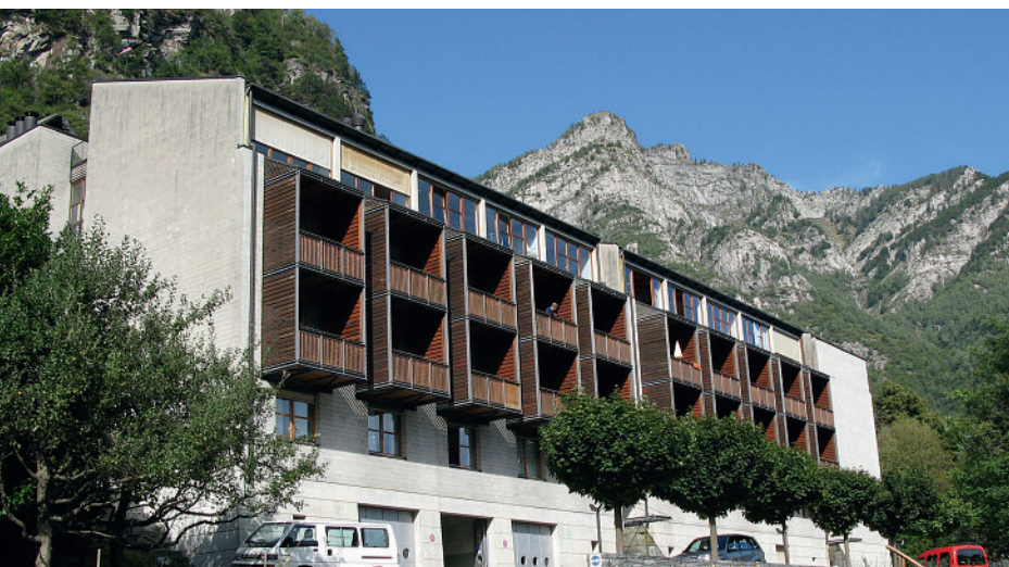
Das Centro: Alle Zimmer haben einen Holzbalkon im historischen Baustil. Sie sind so eingerichtet, dass Betten und Infrastruktur auch für Pflegefälle aufgerüstet werden können.
