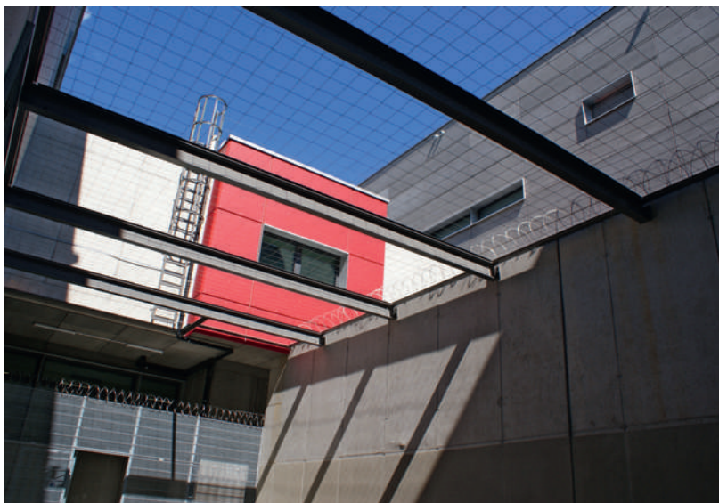
Blick aus dem Innenhof des Regionalgefängnisses in Burgdorf. (Foto: RG Burgdorf)
