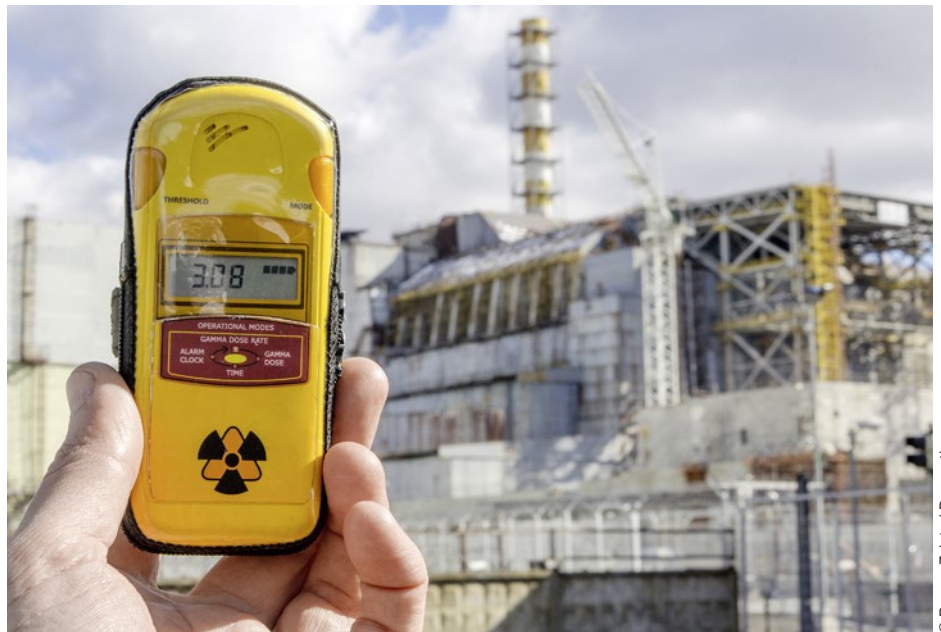
Des rayonnements ionisants à faible dose ont été détectés autour de la centrale nucléaire endommagée de Tchernobyl.
