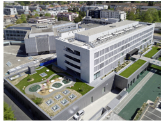
Das Hôpital de La Tour in Meyrin.
